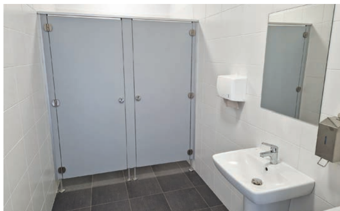
Fot. Łazienka po modernizacji
