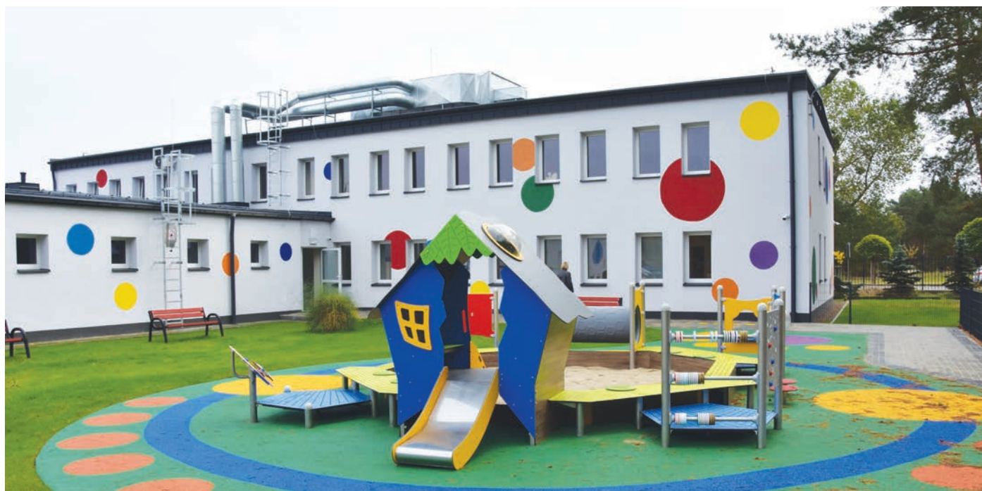
Fot. Modernizacja elewacji Żłobka Miejskiego filia nr 2
