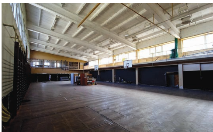
Fot. Hala sportowa przed modernizacją
