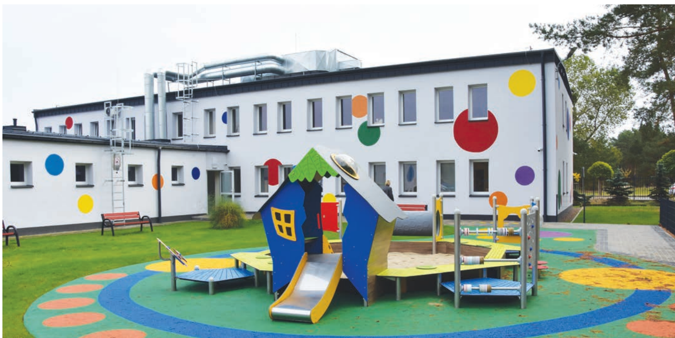
Fot. Modernizacja elewacji Żłobka Miejskiego filia nr 2
