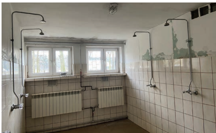
Fot. Łazienka przed modernizacją
