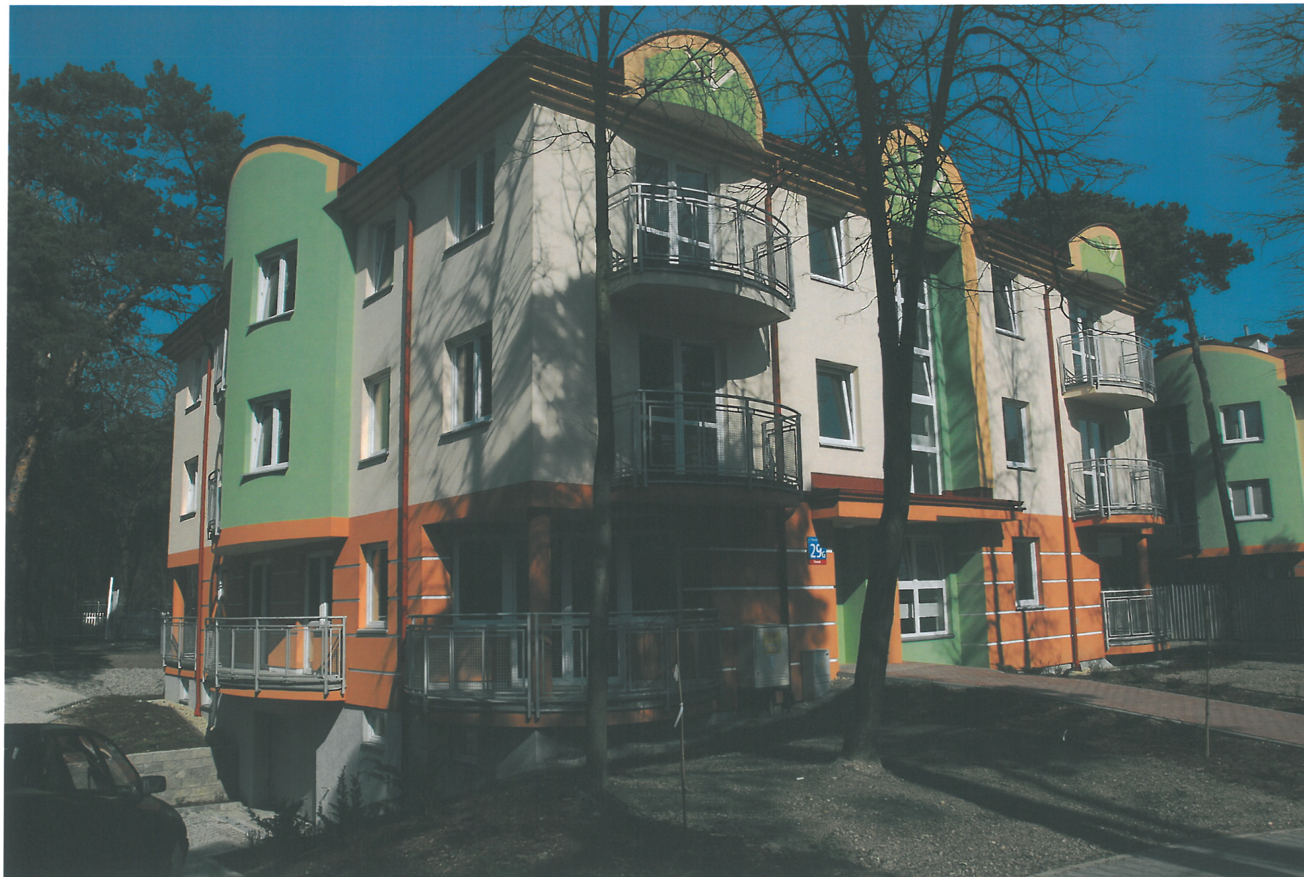
ELEWACJA ZACHODNIA I ELEWACJA POŁUDNIOWA
