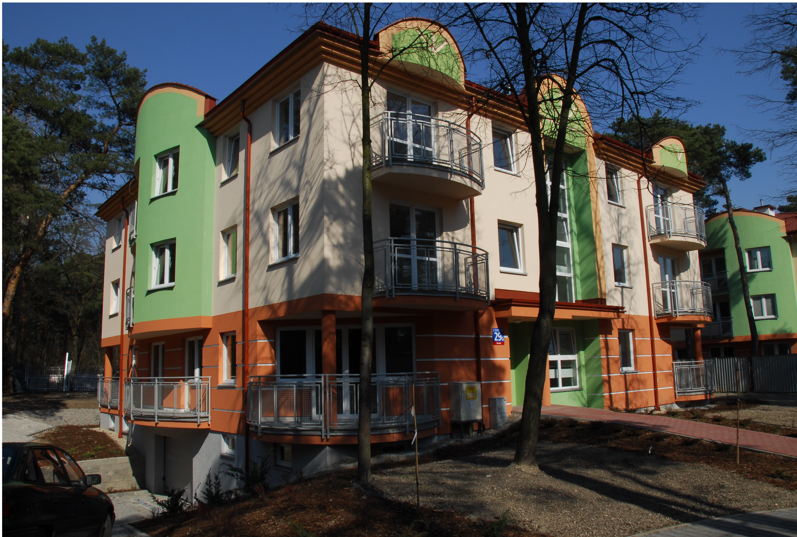
ELEWACJA ZACHODNIA I ELEWACJA POŁUDNIOWA
