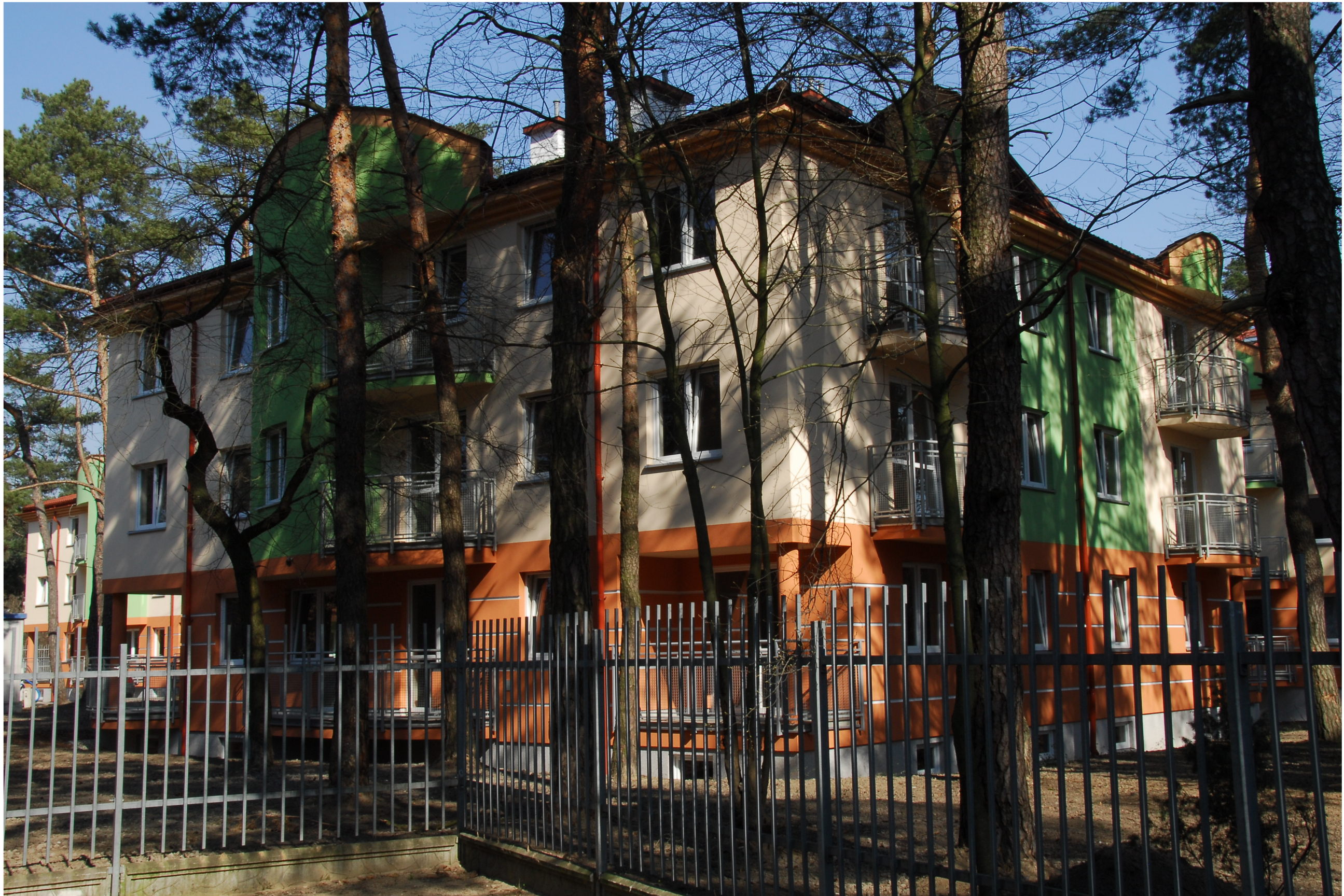
ELEWACJA ZACHODNIA I ELEWACJA POŁUDNIOWA
