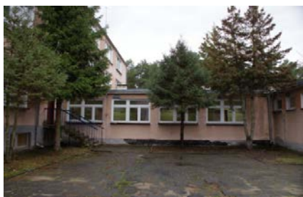
Elewacja SE - łącznik
