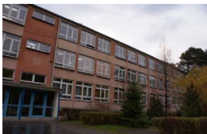
Elewacja SW - budynek główny
