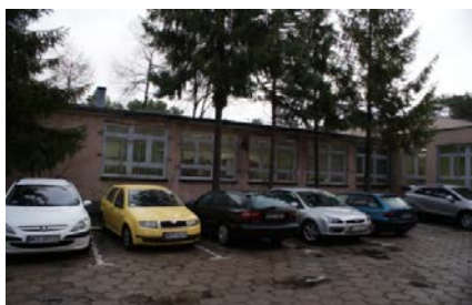
Elewacja SW - część parterowa
