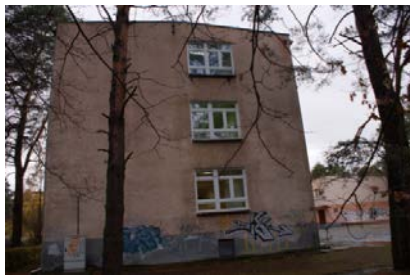
Elewacja SE - budynek główny
