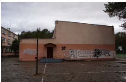
Elewacja SE - sala gimnastyczna
