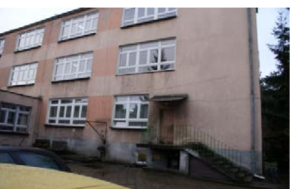
Elewacja NE - budynek główny
