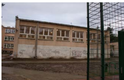
Elewacja NE - sala gimnastyczna
