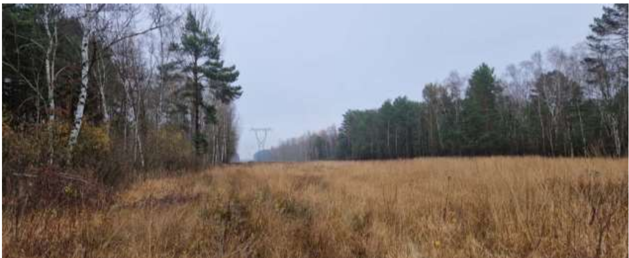
Fot. 1. Pas technologiczny linii 400 kV.
