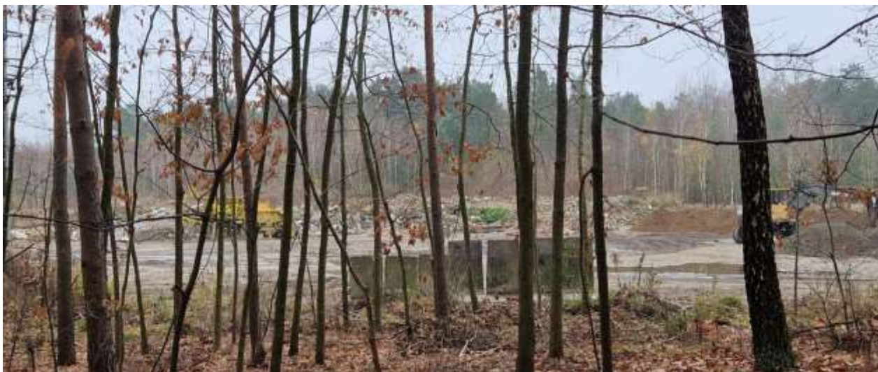
Fot. 10. Plac do składowania i rozdrabniania odpadów budowlanych
