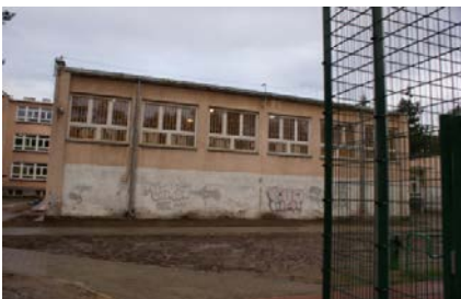
Elewacja NE - sala gimnastyczna
