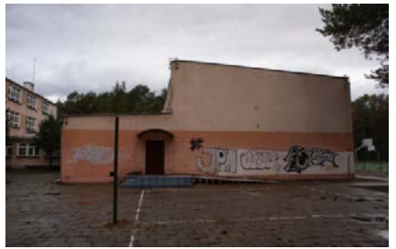
Elewacja SE - sala gimnastyczna
