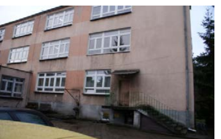
Elewacja NE - budynek główny
