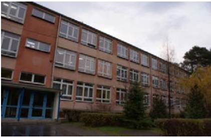
Elewacja SW - budynek główny
