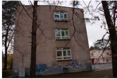
Elewacja SE - budynek główny
