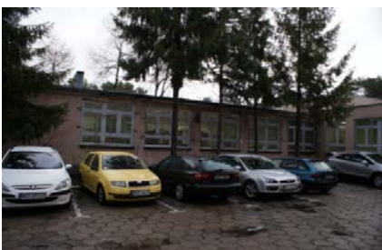
Elewacja SW - część parterowa
