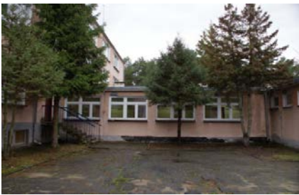
Elewacja SE - łącznik
