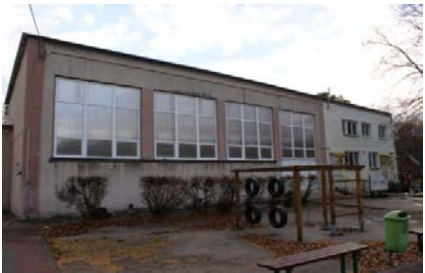
Elewacja północna sali sportowej
