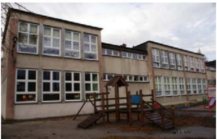
Elewacja wschodnia skrzydła południowego
