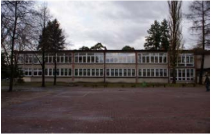
Elewacja południowa skrzydła północnego
