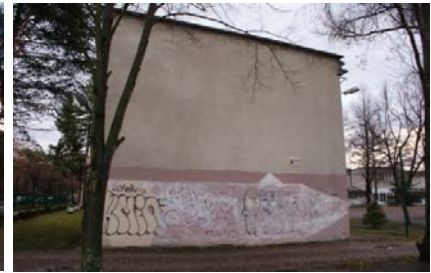
Elewacja zachodnia skrzydła północnego
