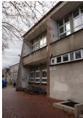
Elewacja wschodnia skrzydła południowego
