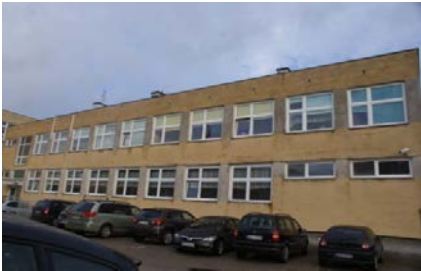
4. Elewacja sw segment 4.3.1.1.
