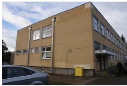
2. Elewacja SE segment 4.3.1.
