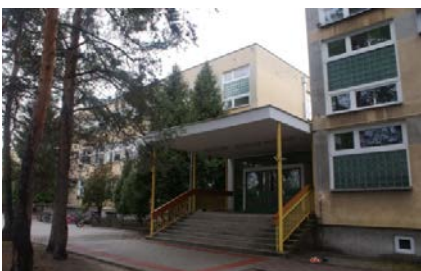
13. Elewacja NE segment 2.3.1. Łącznik nr 2 i segment 1.3.1.
