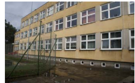
9. Elewacja SW segment 1.3.1.
