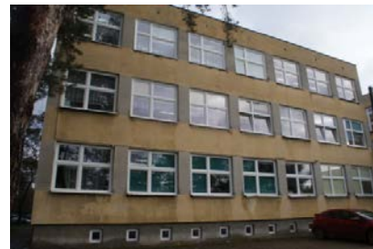
11. Elewacja NE segmentu 1.3.1.
