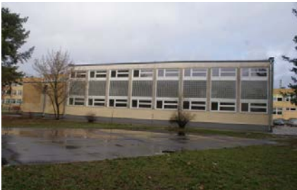
7. Elewacja SW segment 3.2.1.
