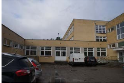
5. Elewacja SE segment 4.3.1.1.
