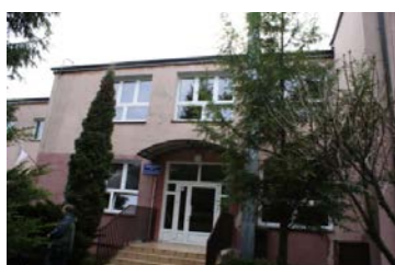
Elewacja północna wejście
