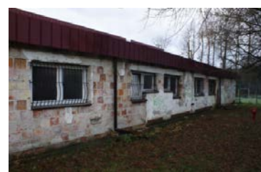
Elewacja wschodnia - sala gimnast.
