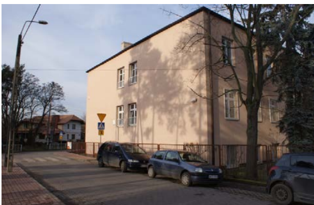
Elewacja południowo-wschodnia - budynek główny
