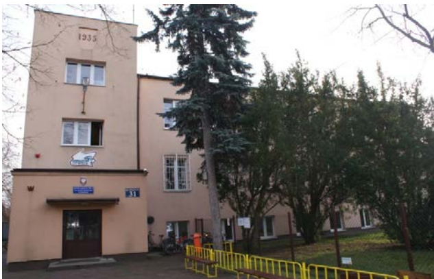
Elewacja północno-wschodnia - wejście główne
