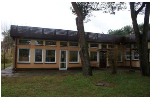
Elewacja północno-wschodnia segment 1
