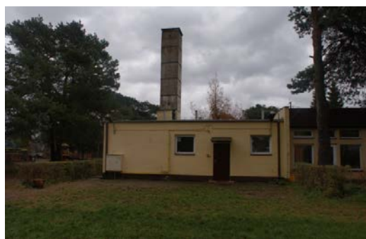
Elewacja północno-zachodnia kotłownia
