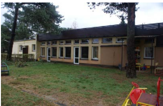
Elewacja północno-zachodnia segment 2
