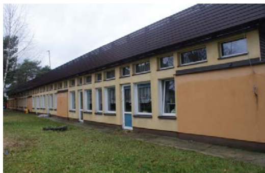
Elewacja południowo-zachodnia segment 1
