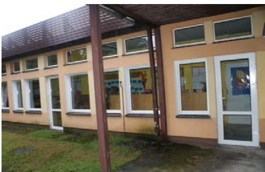
Elewacja północno-wschodnia segment 1
