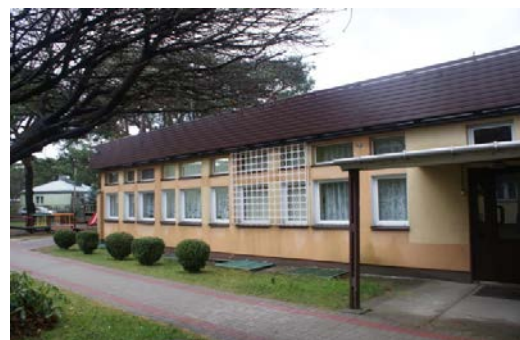
Elewacja Północno zachodnia segment 3
