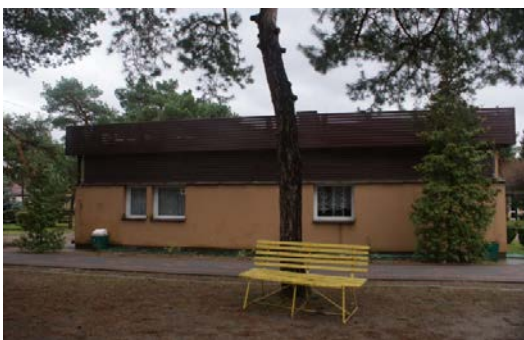
Elewacja północno-wschodnia segment 3
