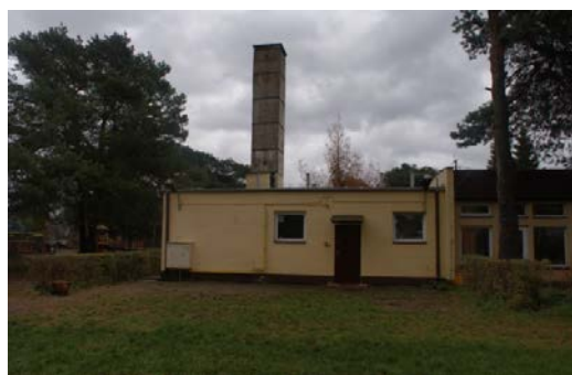
Elewacja północno-zachodnia kotłownia
