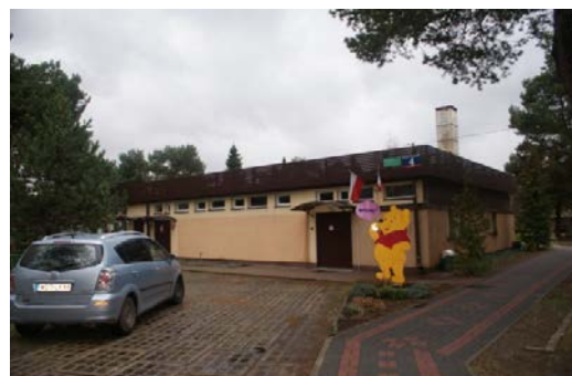
Elewacja południowo-wschodnia segment 3
